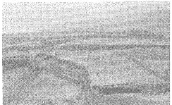
写真2-6 ベンチカット工法の例
