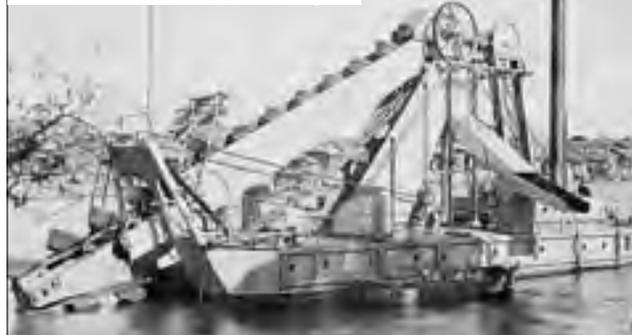
写真3 大河津分水工の高地部掘削
