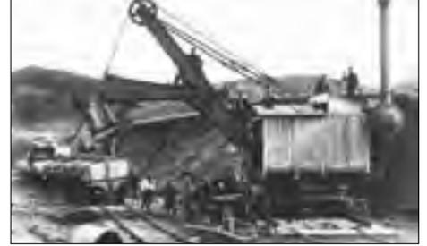
治 27 年 8 月～ 28 年) の戦勝により社会資本整備の拡大が可能となり、河川法が制定され、これによって本格的な機械化土工が導入されることとなった。まず、最初に淀川改修工事の機械化施工を明治 32 年 8 月に開始、改修工事は沖野忠雄が計画、河川土工機械化の正に濫觴となる。投入機械は、仏アッシプルレ製ラダーエクスカベータ (120m<sup>3</sup>/h) × 3、ドコービル 20t 機関車 × 5、30 ポンド軌条、半坪積木造傾斜式土運車 (3m<sup>3</sup> 鍋トロ) 600 台等を輸入。
