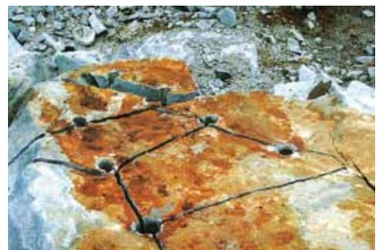
自由面が少なく拘束の大きい地山等では、亀裂幅が大きくなることもありますが、被破碎物内部には膨張圧によって、内部応力が働いていますので、2次破碎は容易です。
