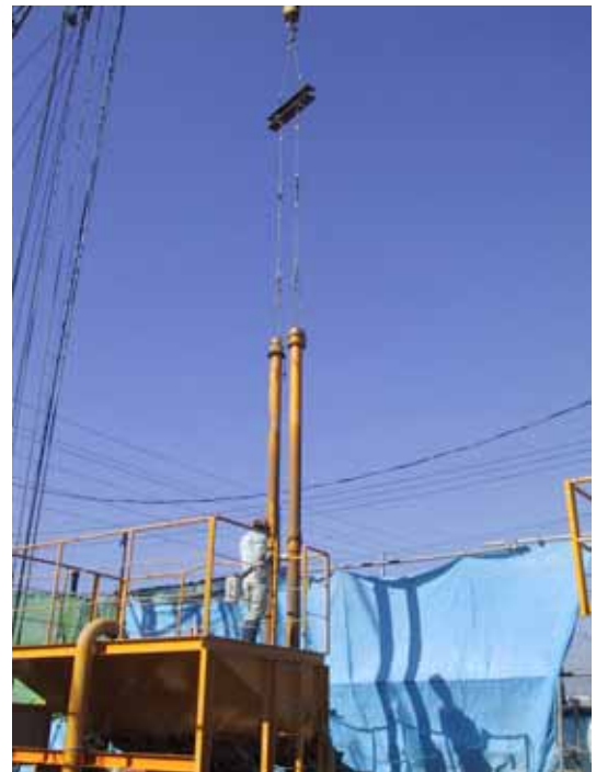
写真-8. トレミー管引き抜き
