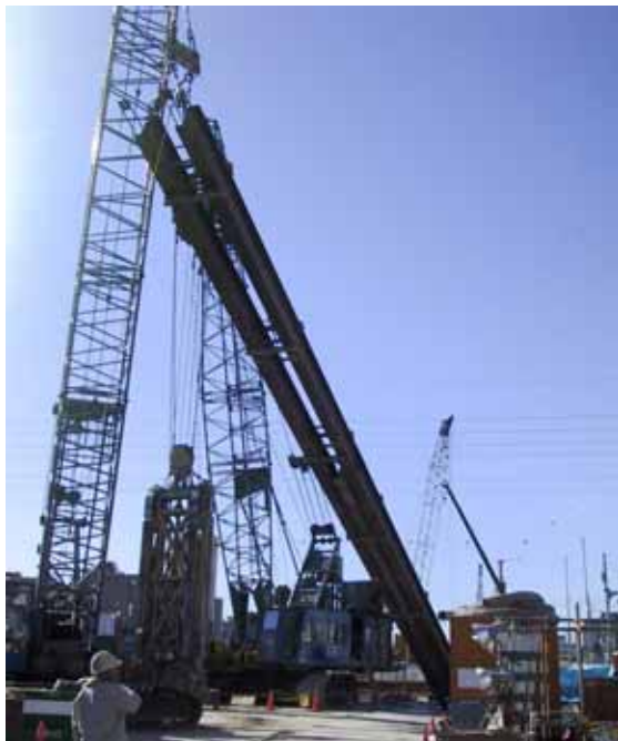
写真 - 5 . 芯材建起こし(その1)
