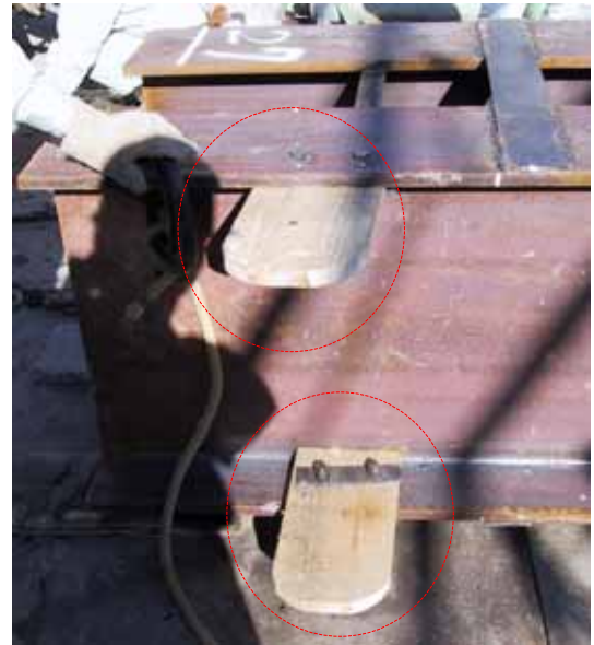
写真-7. 木製スペーサー
