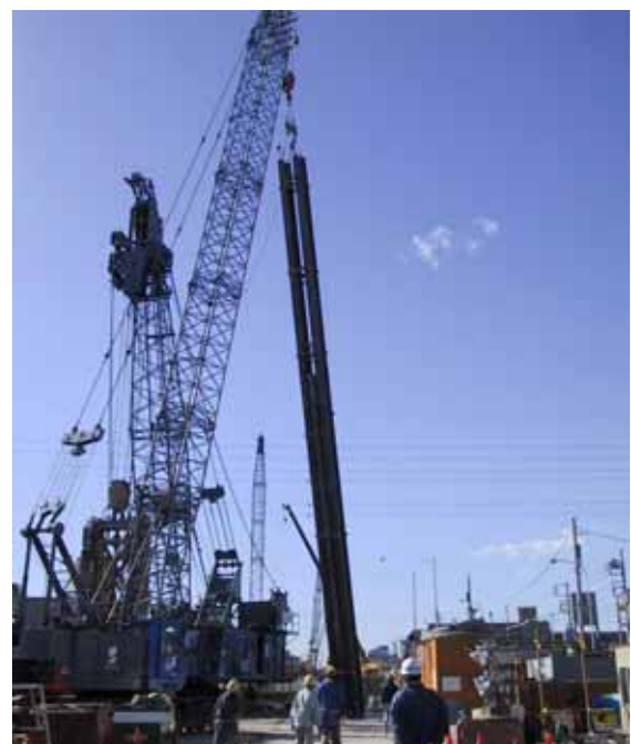
写真 - 6 . 芯材建起こし(その2)
