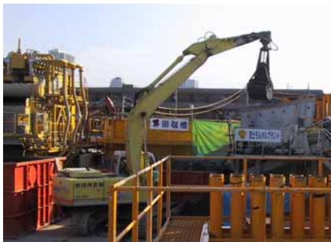
写真 - 11 . ユンボによる掘削土の投入
