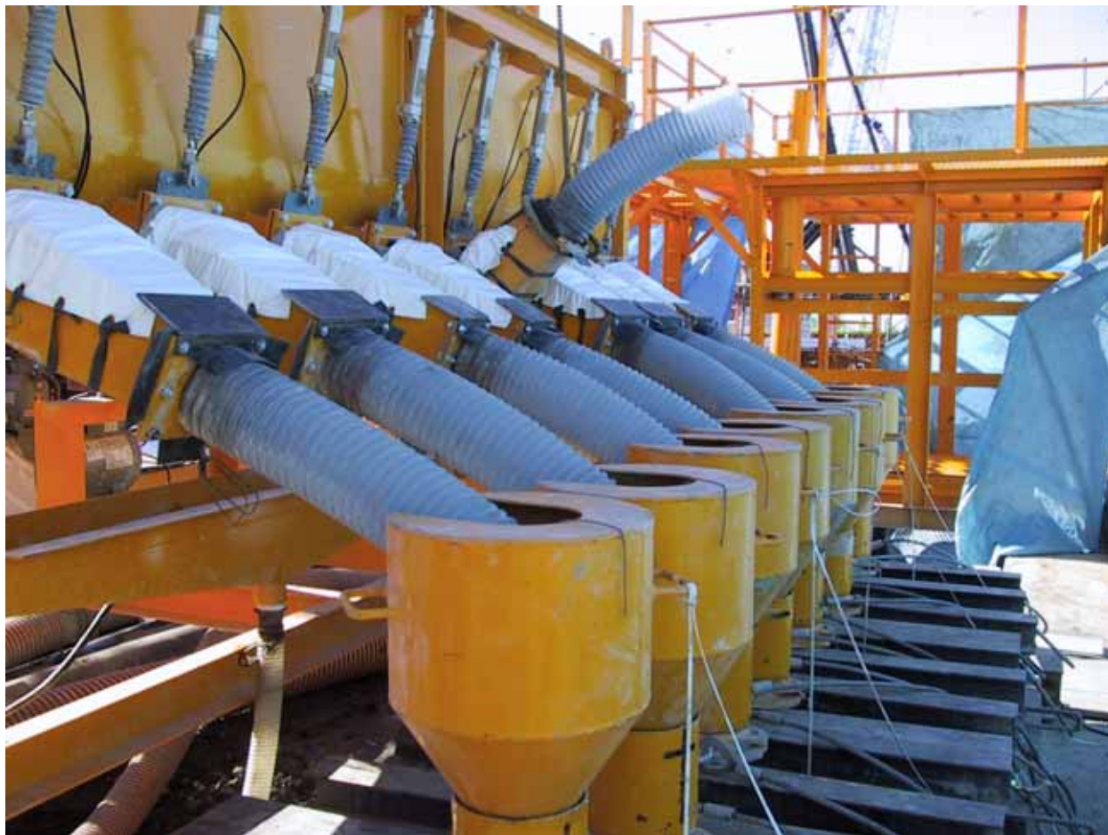
写真 - 10 . 分配機による泥土モルタル打設
