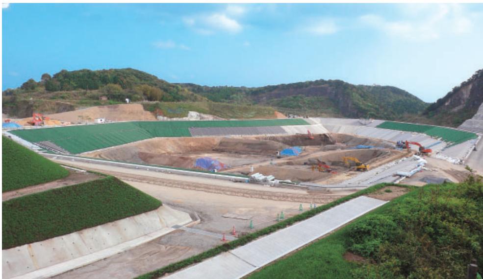
廃棄物処理施設最終処分場建設工事（佐賀県唐津市） 発注者 佐賀県環境クリーン財団 清水建設・松尾建設・岸本組特定建設工事共同企業体様よりご下命
